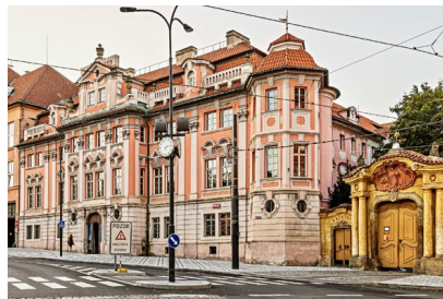
Faust House, Karlovo náměstí 40, Praha 2
